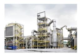
À gauche, unité de production d'acide sulfurique du site d'Engis (source : dossier de presse du site). La réaction étudiée dans cet exercice est réalisée dans une tour de catalyse de cinq étages. Cette réaction est utilisée industriellement afin de produire du trioxyde de soufre, qui sert ensuite à la production d'acide sulfurique, ce dernier étant utilisé en grandes quantités pour divers usages (batteries au plomb, traitement des minerais, fabrication d'engrais, raffinage du pétrole, etc.).
